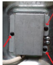
Po instalaci napájecího kabelu přišroubujte kovový kryt pomocí tří šroubů.
